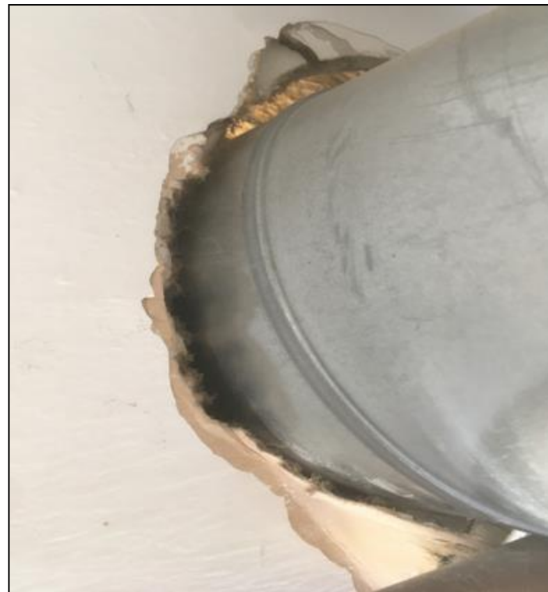
Слика 9. Отвор за клима-уређај открива попречни пресек унутрашњег зида у постојећој згради (гипс, картон, фарба) (фото: С. Сушић)
