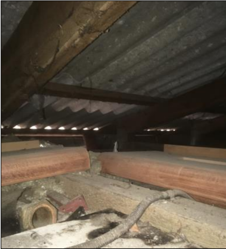
Слика 6. Кровна покривка која садржи азбест (фото: С. Сушић)
