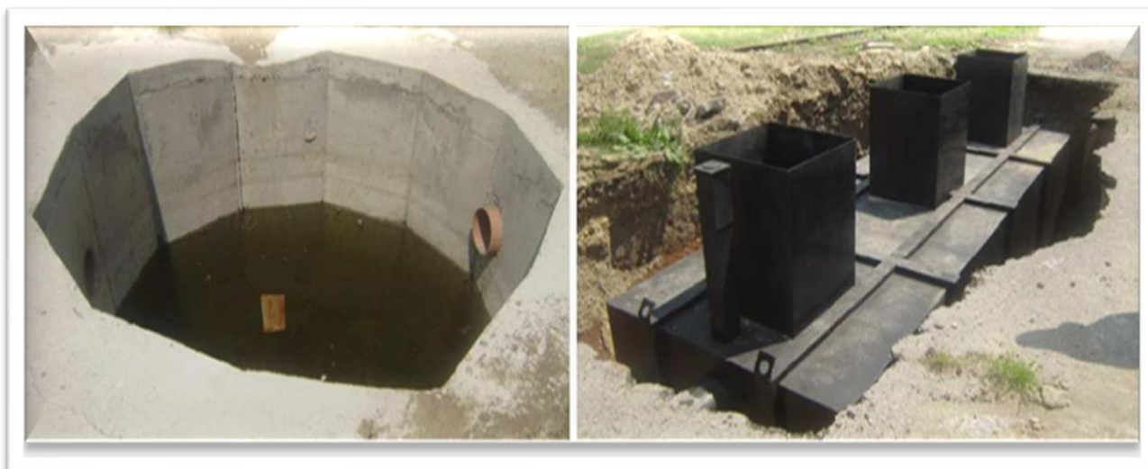
Слика бр.6 - Сепаратор масти и уља
